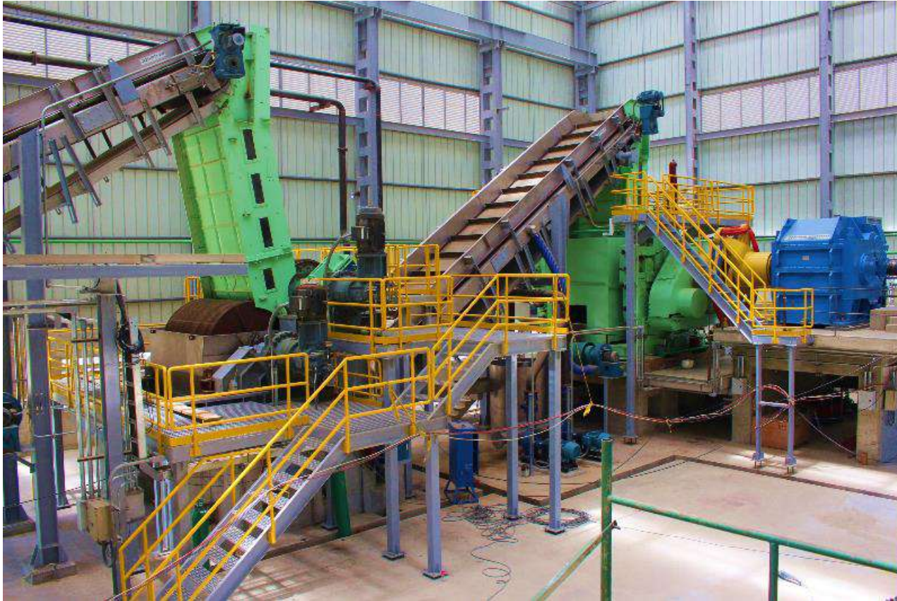
ELECTROMONTAJE Y OVERHAUL DE EQUIPOS DE MOLINO MILL HOUSE
