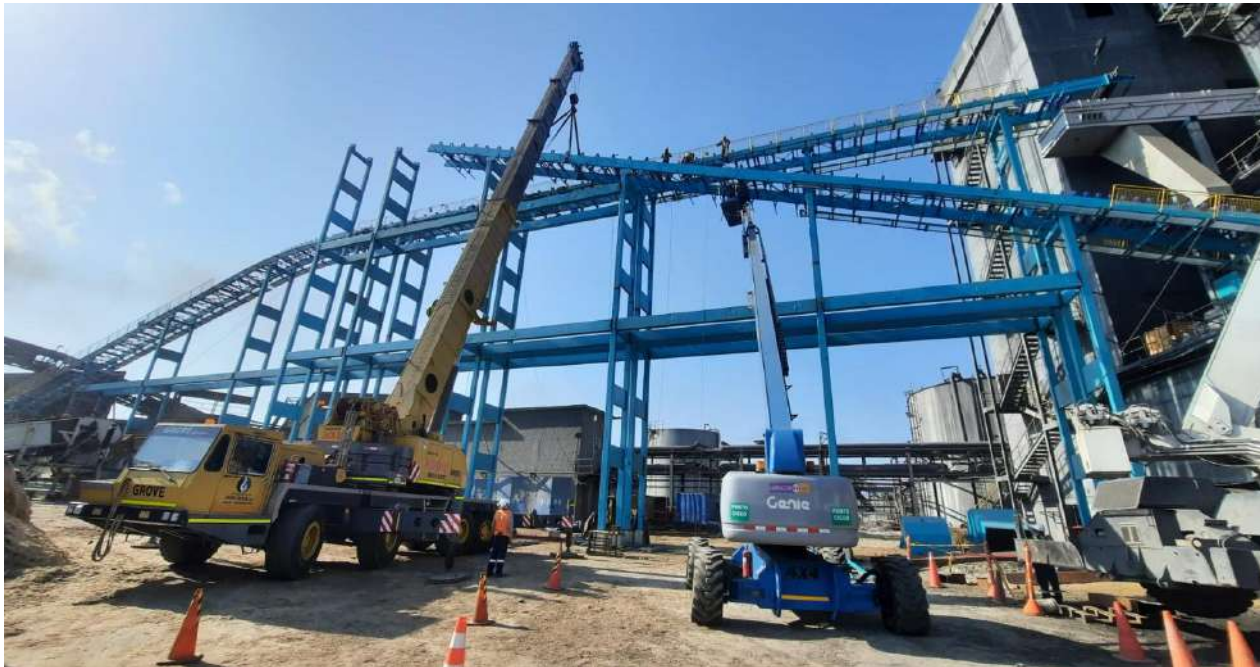
FABRIC. Y MONTAJE DE TRANSPORTES DE CAÑA
