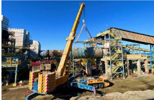
MONTAJE DE NUEVO TAMBOR SECADOR 2
