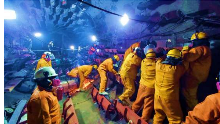
REFORZAMIENTO INTERNO DE SECADOR 1
