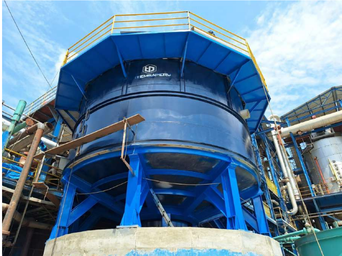
FABRIC. Y MONTAJE DE CLARIFICADOR SRI
