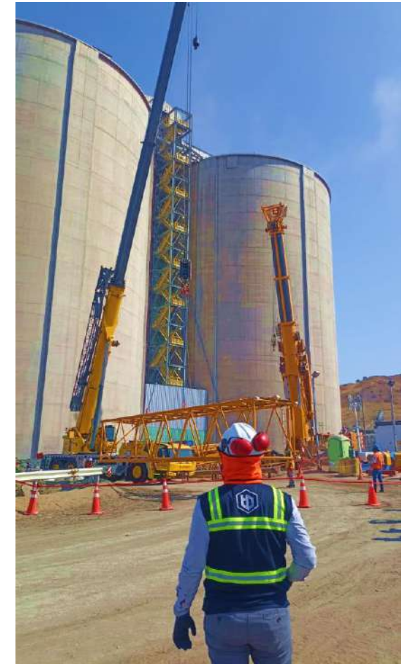
CAMBIO DE ELEVADOR DE CANGILONES
