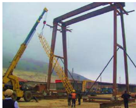
FABRIC. Y MONTAJE DE 03 GRÚA PORTICO MINERA TINTAYA
