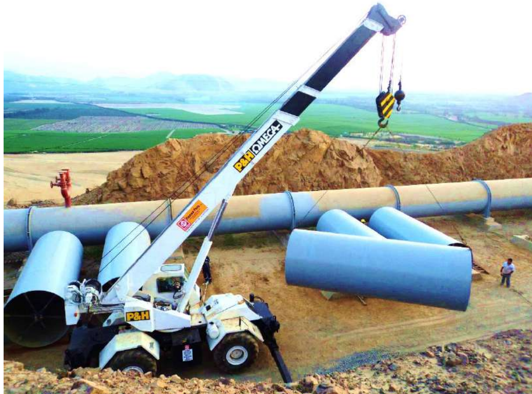
MONTAJE DE 3RA LINEA DE SIFON VIRU
