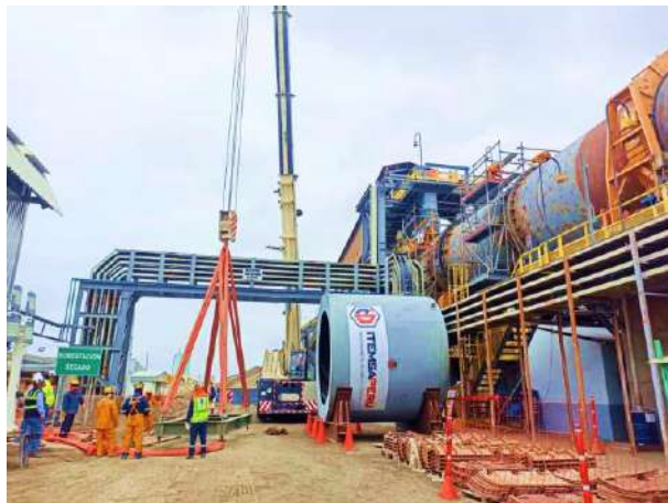
FABRICACION Y MONTAJE DE INJERTO DE SECADOR 1
