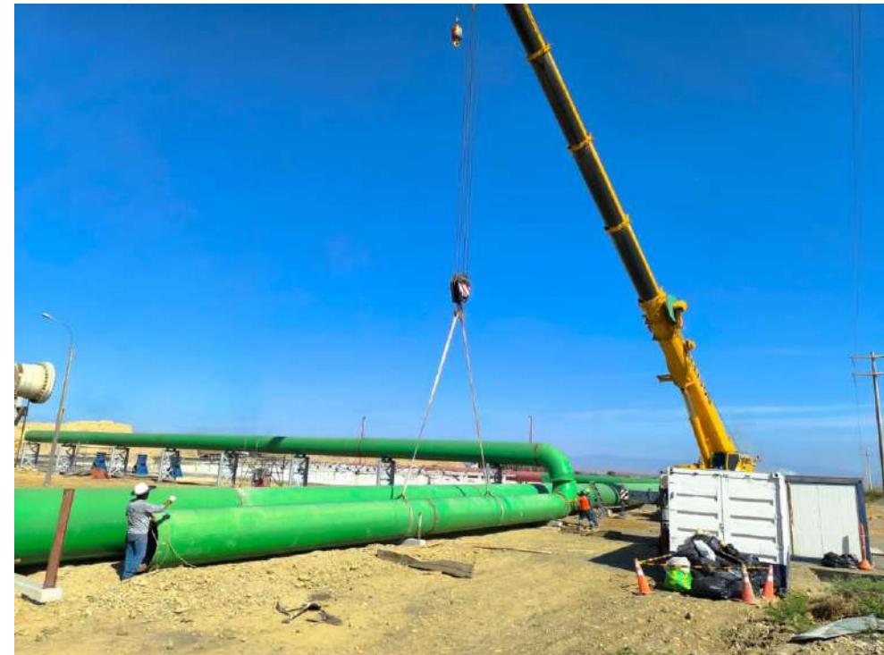
MONTAJE DE SISTEMA DE AGUA FRIA Y CALIENTE
