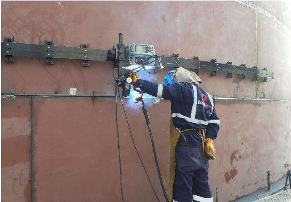
CONSTRUCCION DE TANQUE 4000 M3
