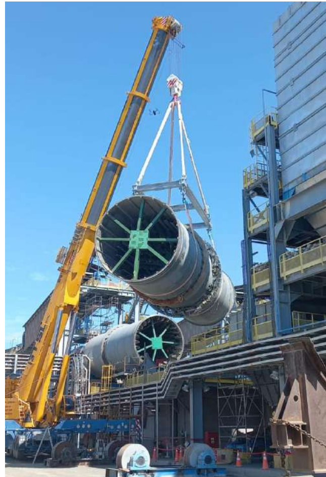
MONTAJE DE NUEVO TAMBOR SECADOR 1
