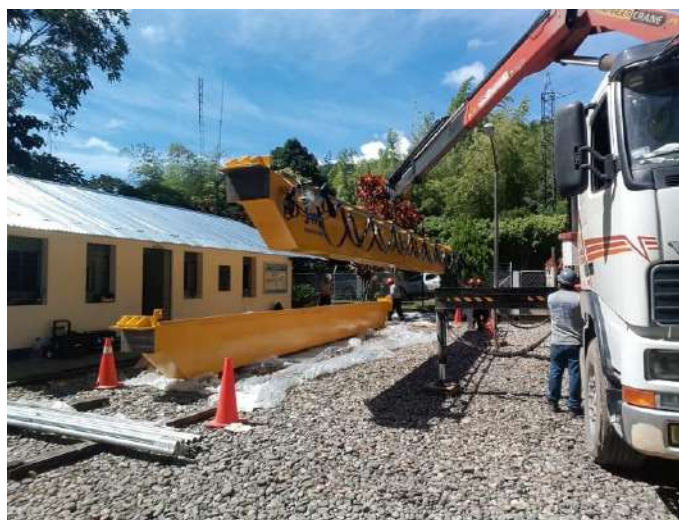
FABRIC. Y MONTAJE DE GRÚA PUENTE CAP 10 TON
